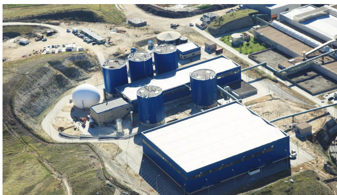
Vista aérea de la planta.
