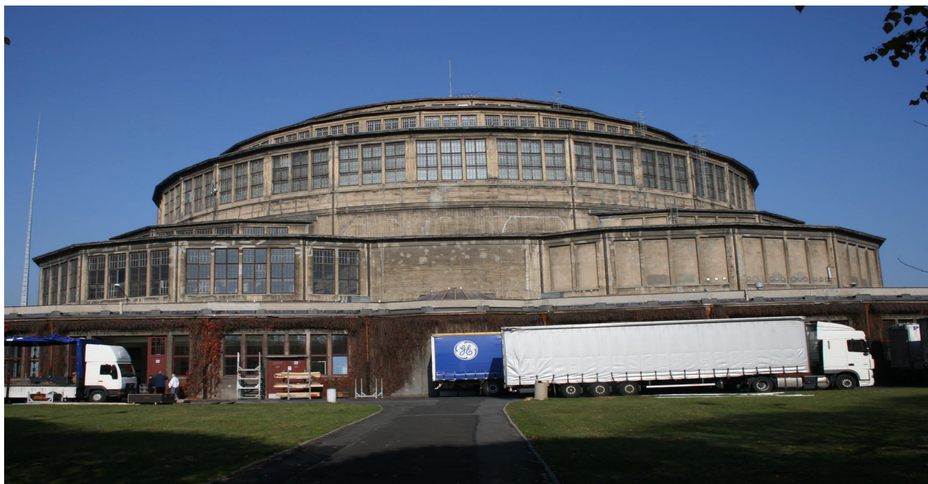
Vista exterior del edificio.
